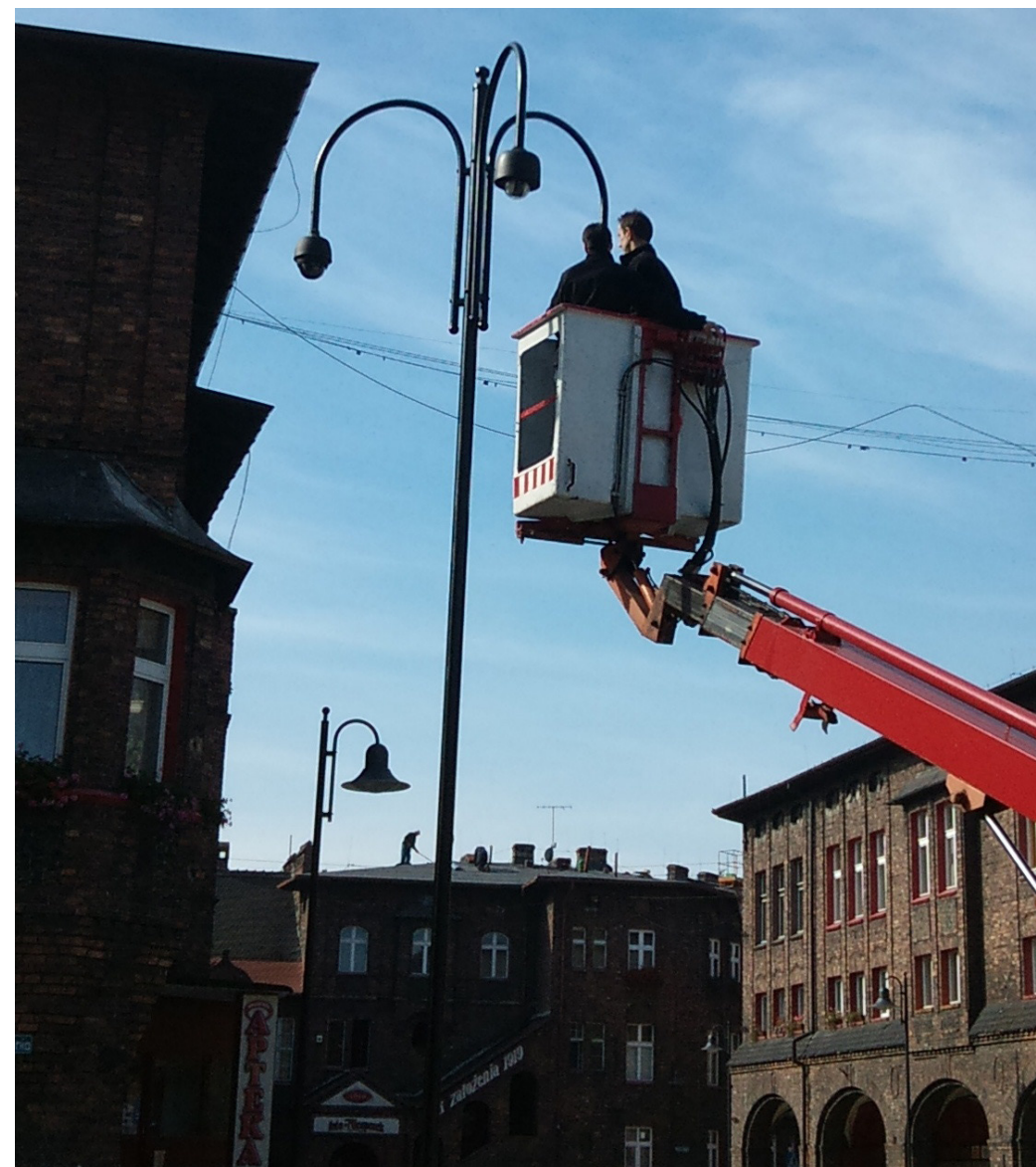
6 X 2010, montaż kamer systemu monitoringu wizyjnego na nikiszowieckim rynku fot. ze zbiorów Stowarzyszenia Fabryka Inicjatyw Lokalnych
