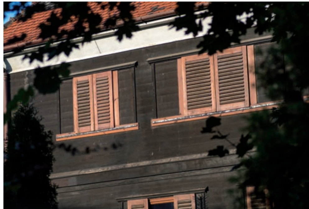
Fragment willi z drewnianych płyt przy ul. Solskiego 1 (także na okładce). Foto Adam Maniura
