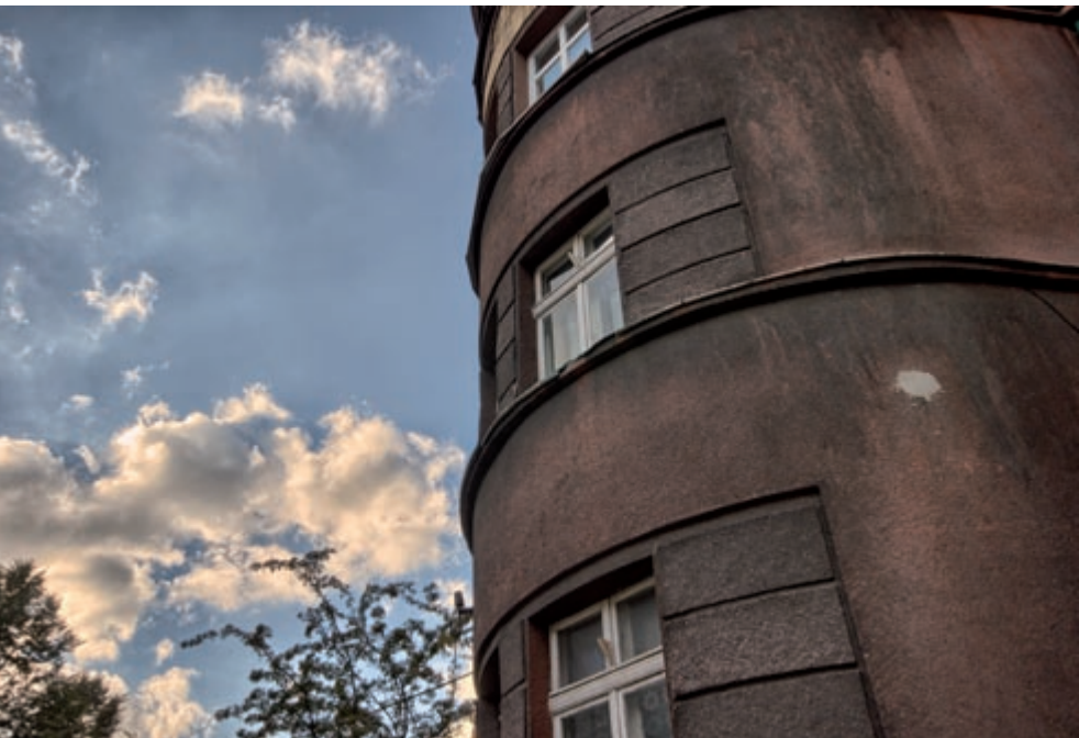
Fragment kamienicy - róg ul. Pułaskiego i Wyspiańskiego. Foto: Adam Maniura
