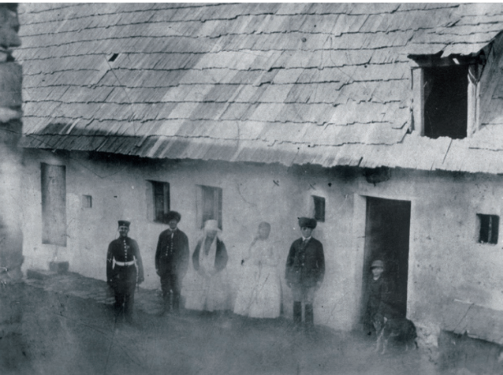
Chata przy obecnej ul. Witczaka 30 (przypuszczalnie koniec XIX w.); fot. ze zbiorów Małgorzaty Sprot
