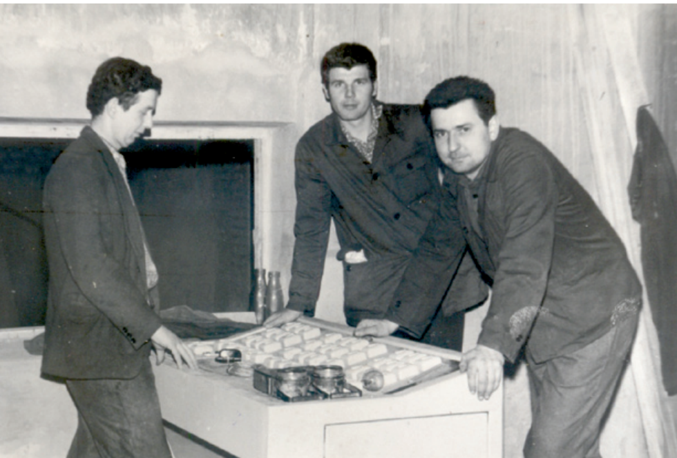
Dom kultury – pomieszczenie sterownicze i rozdzielnia prądu, 1968 r.; fot. ze zbiorów Henryka Psoty
