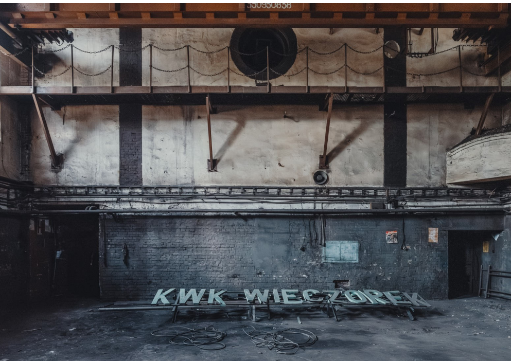
Ostatnie odwiedziiny wewnątrz budynków szybu „Pułaski” w lipcu 2025 r. – na moment przed rozpoczęciem prac budowlanych.
