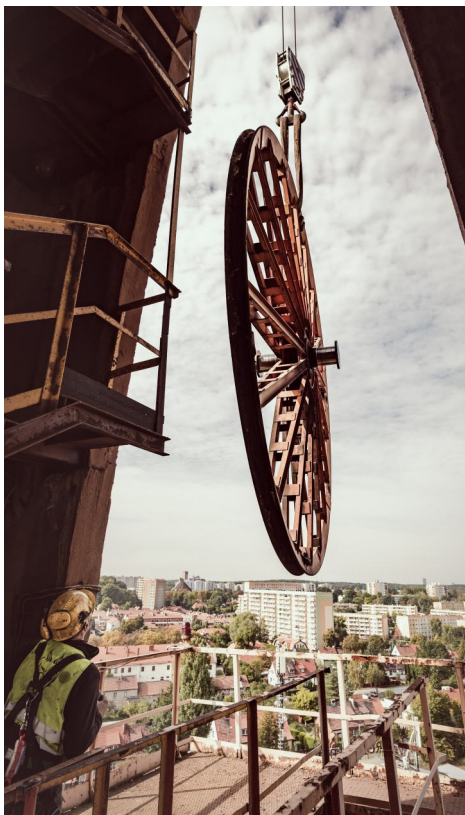
Trudny etap wyciągania koła linowego na wieży szybu „Roździeński”.
