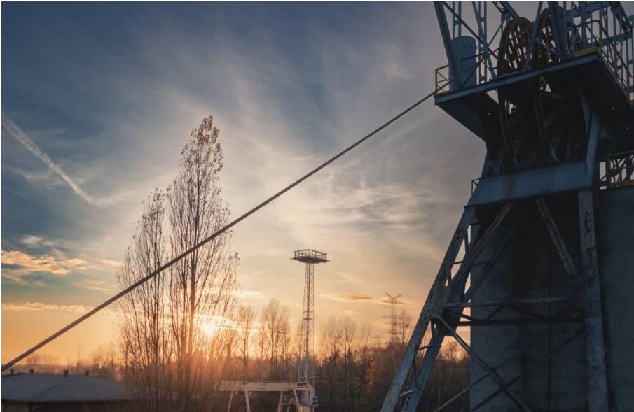
Etap demontażu lin wyciągowych wraz z klatkami zjazdowymi w szybie „Poniatowski” – listopad 2017 r.
