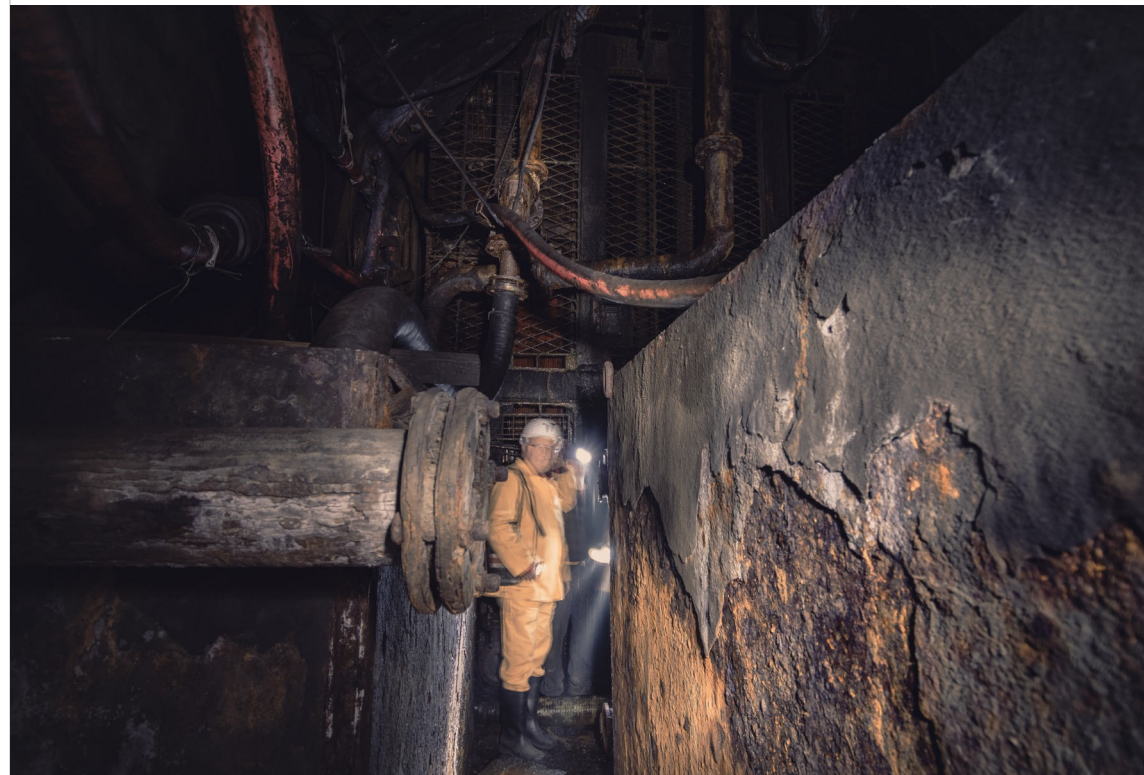
Wnęka w szybie na poziomie 362 m to pozostałość po podszybiu. Niewielką głębokość zajmują spore zbiorniki retencyjne wody pompowanej na powierzchnię. Za nimi znajduje się betonowa tama, a za nią pozostały wspomnienia sprzed 26 lat.
