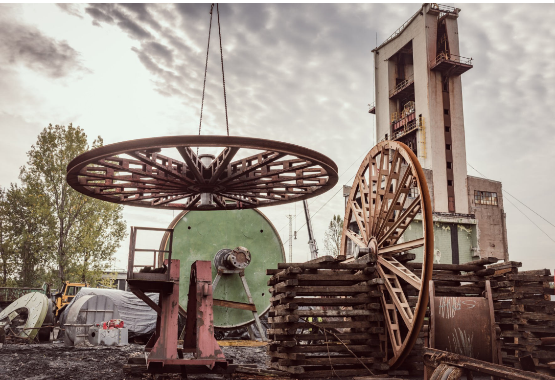
Etap demontażu kół linowych z wieży wyciągowej szybu „Roździeński” – wrzesień 2021 r. W czerwcu 2024 r. wyburzono żelbetową konstrukcję ciężkim sprzętem. Sama rura szybowa została zachowana i częściowo zatopiona – pełni funkcję studni odwadniającej z zainstalowanym wewnątrz systemem pomp głębinowych.
