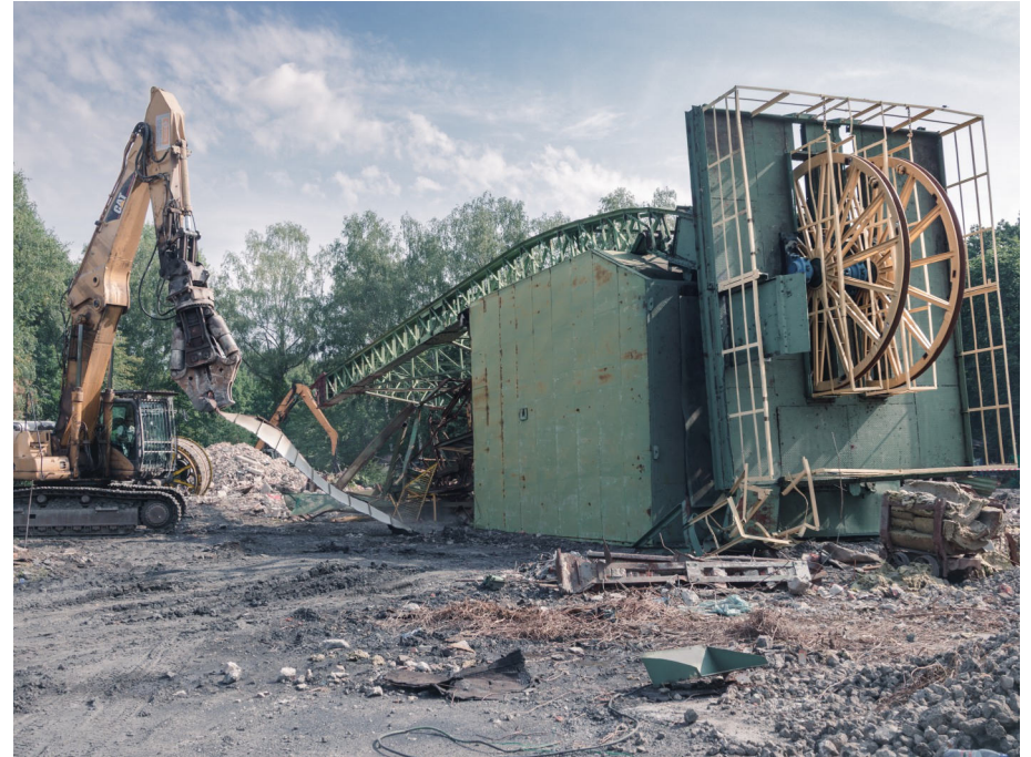
Wyburzenie wieży wyciągowej szybu „Wschodni” – sierpień 2019 r.
