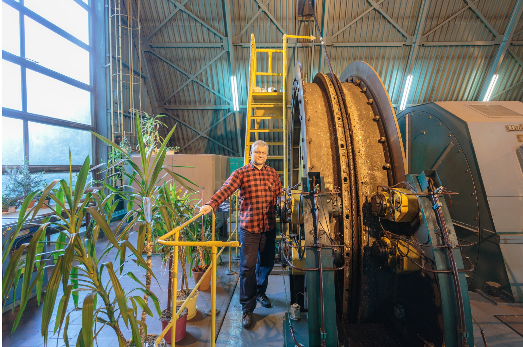
Maszyna wyciągowa szybu „Giszowiec”. Maszynista p. Sławomir Osuch.
