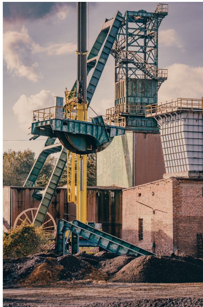
Demontaż wieży wyciągowej szybu „Giszowiec” – październik 2023 r.
