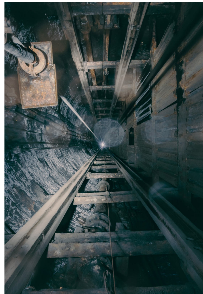
Widok w szybie z poziomu 400 m na powierzchnię.
