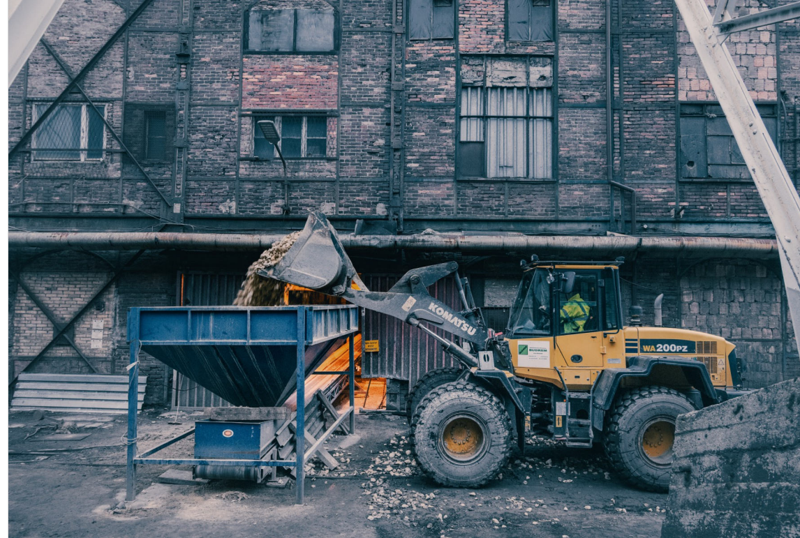
Rozpoczęcie zasypywania szybu kruszywem o odpowiednio dobranym składzie – luty 2020 r.
