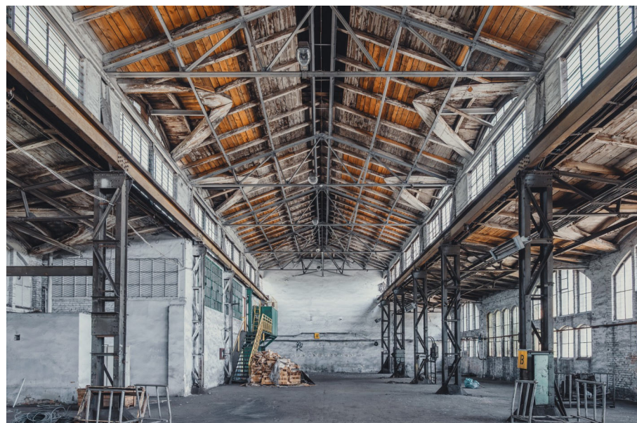
Hala magazynu głównego.
